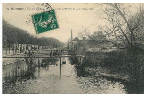
Passerelles sur l'Odet
