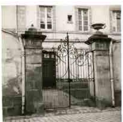
Entrée de l'hôtel rue Laënnec
