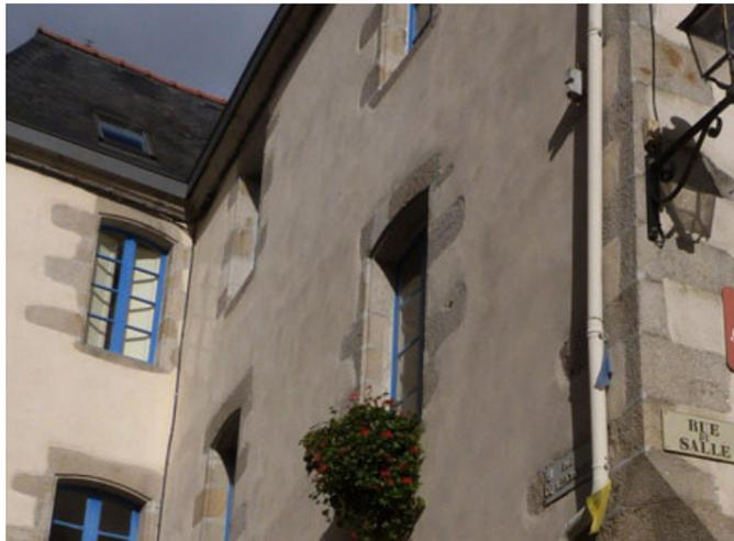
Enduit traditionnel ne laissant apparentes que les pierres d'encadrement et les chaînages d'angles
