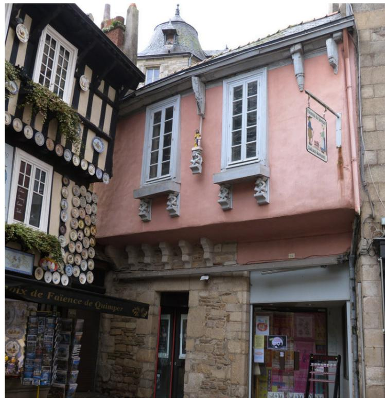
Façade à pans de bois recouverte d'un enduit et d'un badigeon
