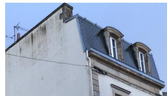
Toiture à la Mansart, toiture brisée et ses lucarnes
