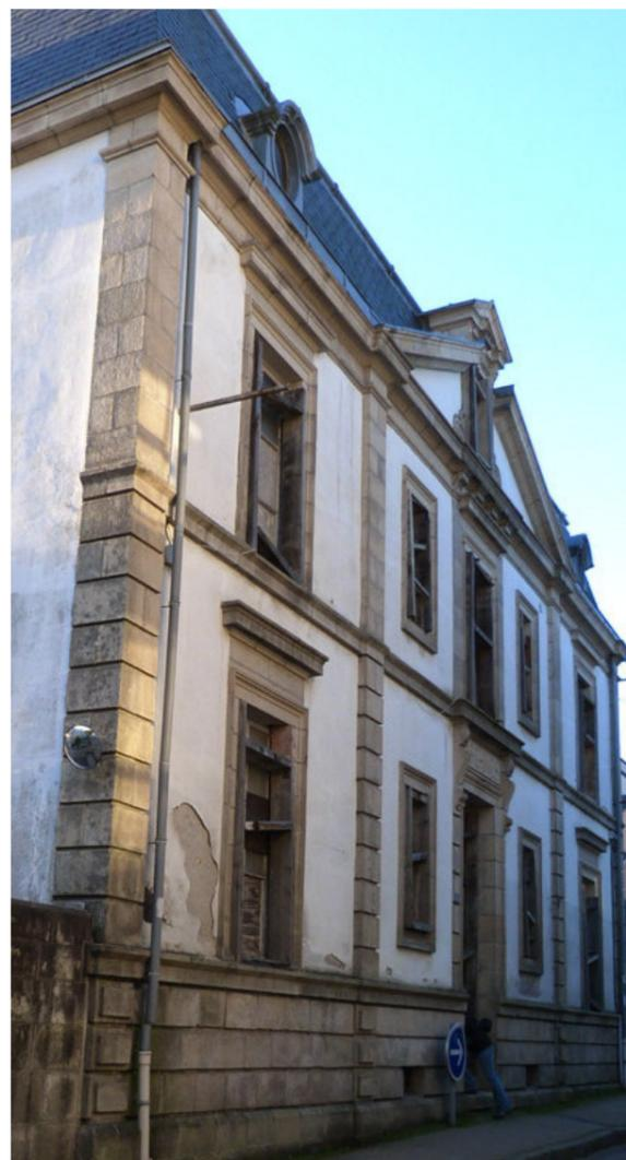
Pilastres, soubassement, bandeau et corniche en pierre de taille sur une façade recouverte d'un enduit
