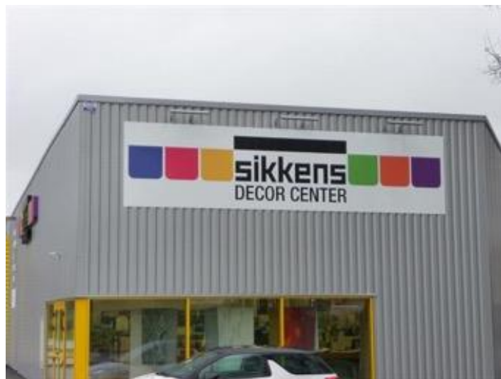
Enseignes parallèles au mur en zone d'activités, Quimper, 2021
