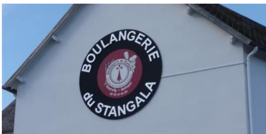
Enseigne parallèle avec un éclairage LED, Quimper, 2021
