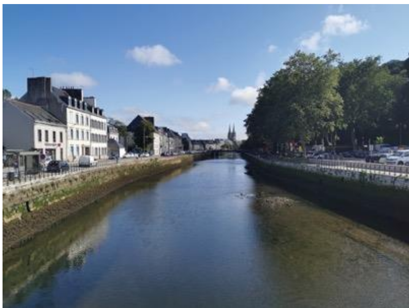
Cours de l'Odet en centre-ville de Quimper, vue vers le Nord, 2021
