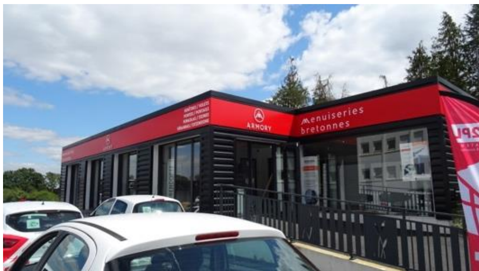
Enseignes parallèles au mur en zone d'activités, Quimper, 2021
