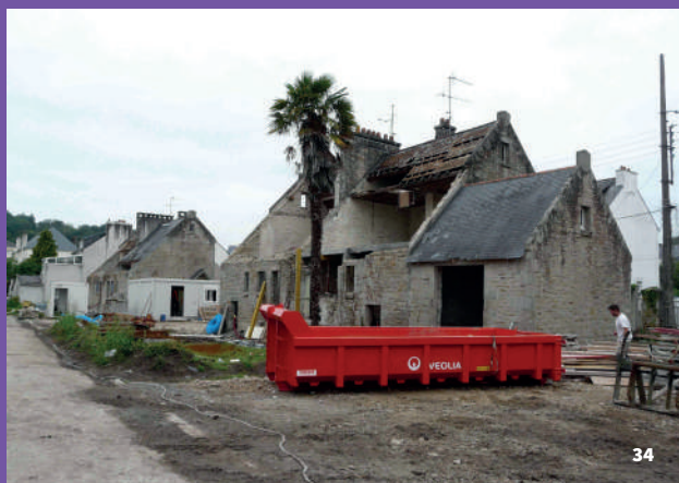
32 et 33. La Cité du Gaz en chantier
