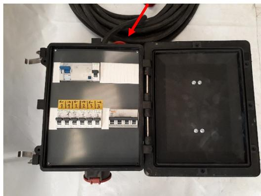
**Disjoncteurs + Protection différentielle 30 mA**
