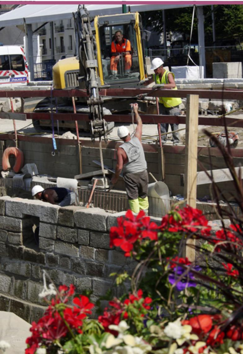
**D**epuis février 2013, les engins de chantier se sont succédé rive gauche le long du parking de la Résistance, au centre-ville de Quimper. Les murs des quais particulièrement dégradés ont été reconstruits à l'identique. Les travaux vont s'achever avec la remise en état de la voirie.
