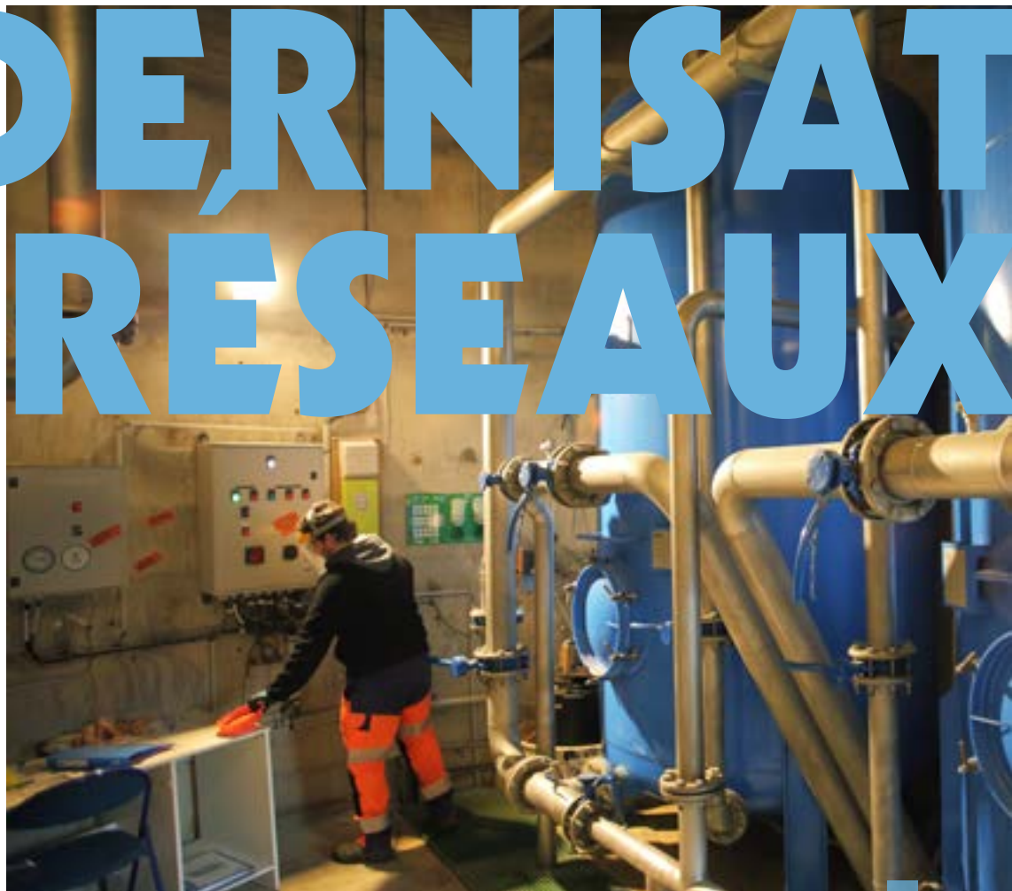
La station de traitement avec filtre à neutralité pour les deux cuves de 500 m 3 du château d'eau de Ty Fao à Briec.
