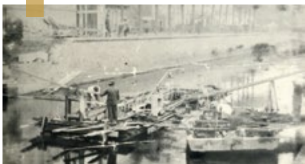
Construction du pont du théâtre en 1901.
