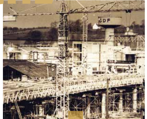
Pont de l'Eau Blanche en construction - 1966
