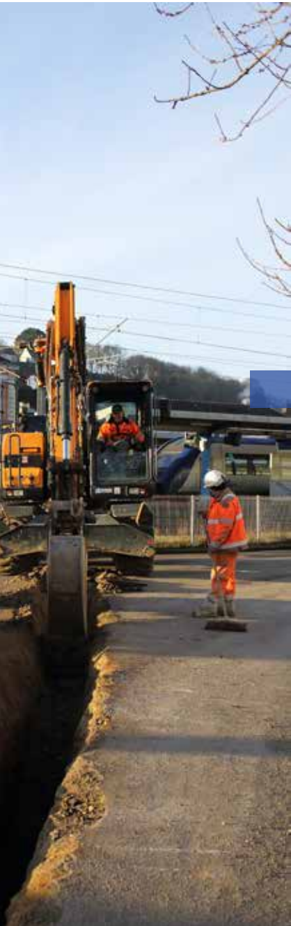
Des travaux sur les réseaux sont actuellement menés impasse de l'Odet à Quimper.
