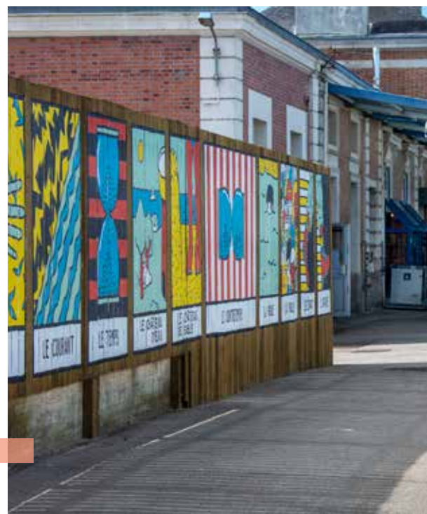
Le chantier est aussi l'occasion d'actions artistiques, comme la fresque que Baptiste Alchourroun et Vincent Croguennec ont peinte sur une palissade le long du quai A.
