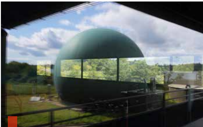
La station d'épuration de Quimper Bretagne Occidentale située au Corniguel face à la baie de Kerogan.
