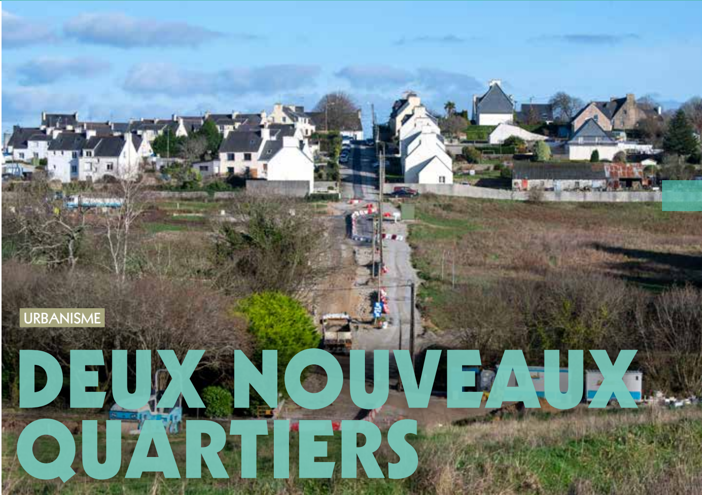
Les travaux d'aménagement et de construction sont en cours.
