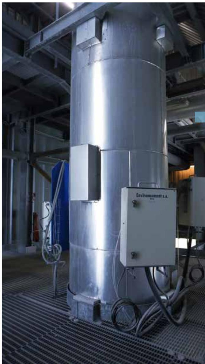
Le filtre à manche de l'usine capte les poussières et les particules polluantes issues de l'incinération. Les fumées dégagées sont épurées et contrôlées en continu avant leur sortie dans l'atmosphère.
