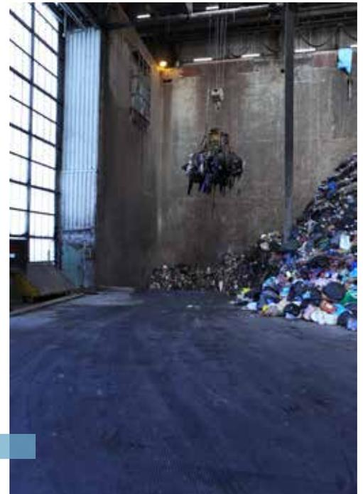
Un grappin saisit une tonne de déchets par prise, les mélange pour les homogénéiser et les dépose dans les trémies d'alimentation des deux fours.
