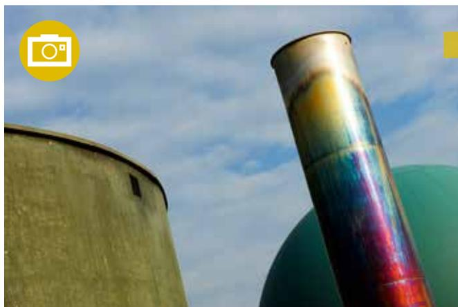
L'excédent de biogaz est brûlé à l'aide d'une torchère. Fin 2016, il sera injecté dans le réseau de GRDF.
